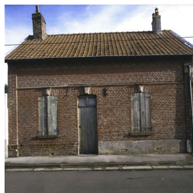
2 rue Saint-Pierre, vue de la façade antérieure du logement. Phot. Thierry Lefébure IVR22_20038001082XA
