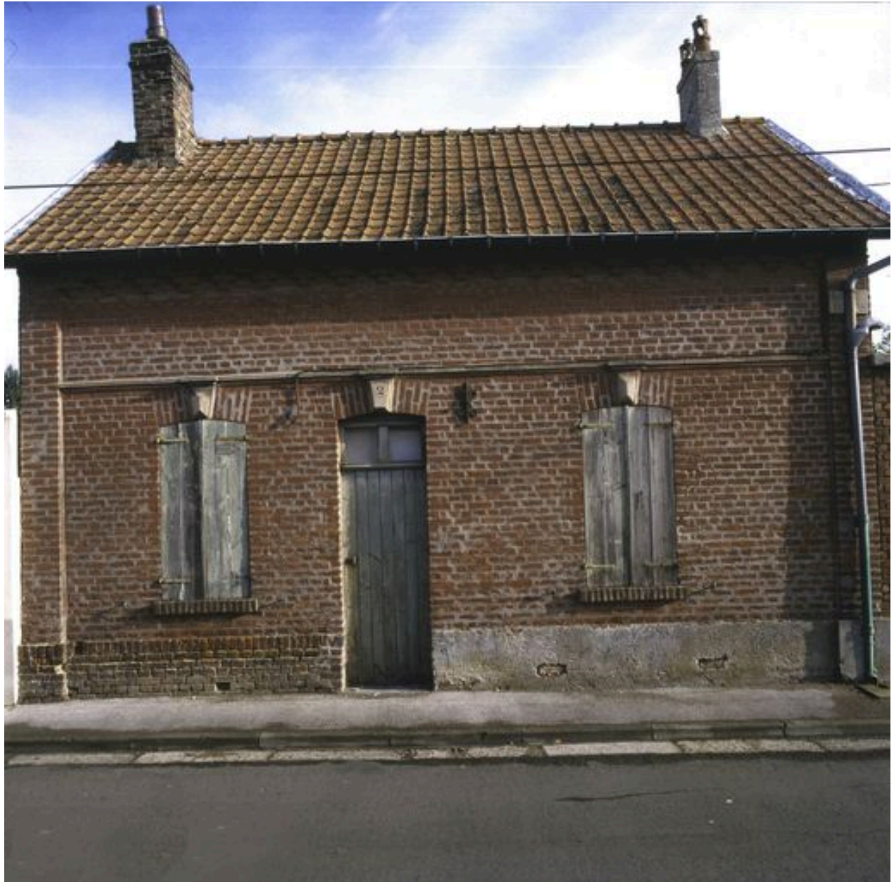
2 rue Saint-Pierre, vue de la façade antérieure du logement.
