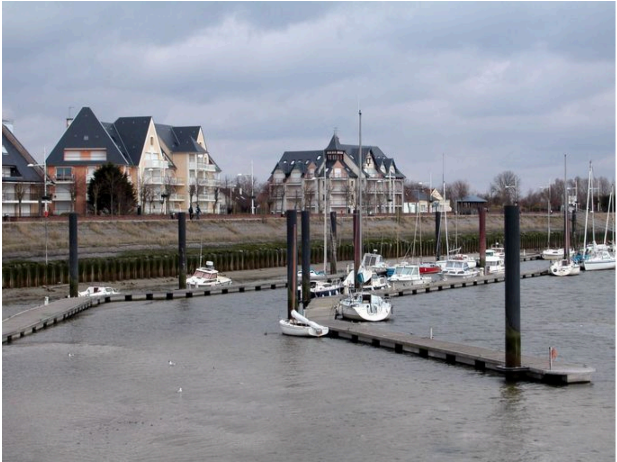
Les immeubles récents construits le long du 'chemin de la digue'.
