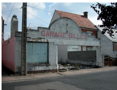
Le garage Saint-Gilles, désaffecté, rue Florentin-Lefils (1985 AP 74). Phot. Elisabeth Justome IVR22_20058003753NUCA
