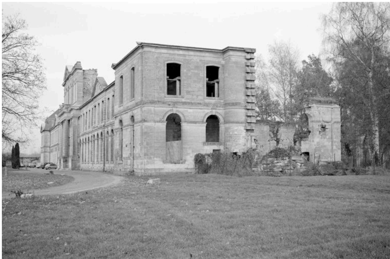
Vue d'ensemble sud des vestiges des bâtiments abbatiaux ayant servi de filature.
