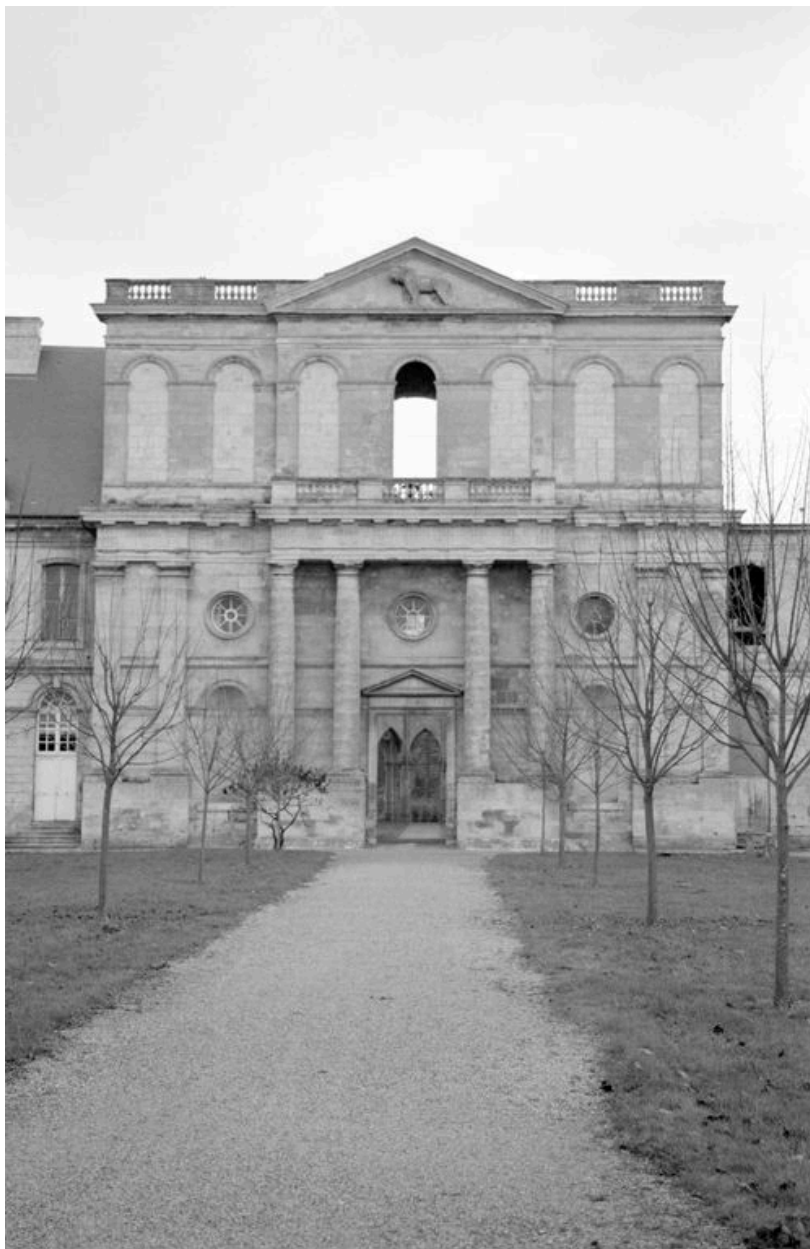
Façade occidentale de l'église abbatiale.
