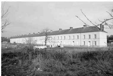
Logements ouvriers. Phot. Bertrand Fournier IVR22_19996001572Z
