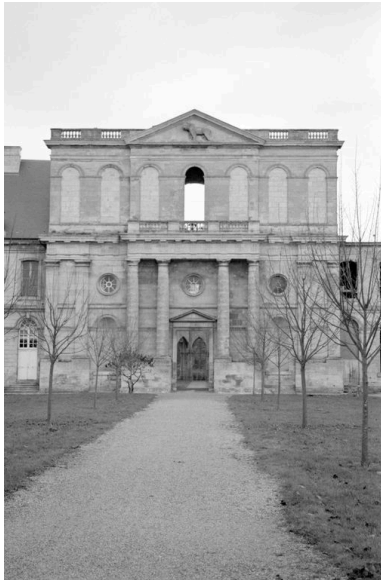
Façade occidentale de l'église abbatiale. Phot. Bertrand Fournier IVR22_19996001565Z
