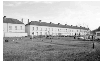
Logements ouvriers. Phot. Bertrand Fournier IVR22_19996001573Z
