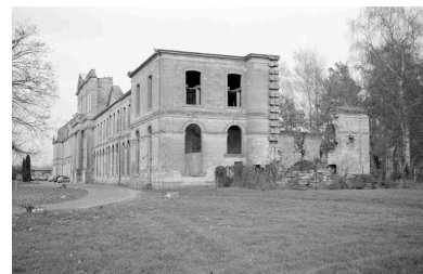
Vue d'ensemble sud des vestiges des bâtiments abbatiaux ayant servi de filature. Phot. Bertrand Fournier IVR22_19996001570Z
