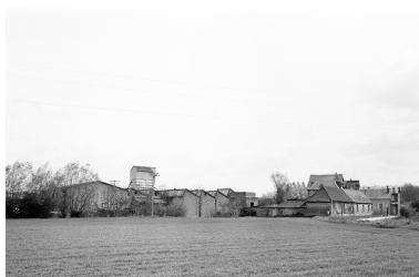
Vue partielle, flanc sud. Phot. Patrick Glotain IVR22_19918000145X
