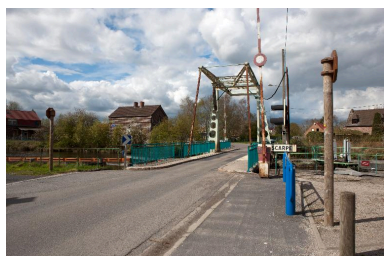
Le pont mobile sur la Scarpe. Phot. Pierre Thibaut IVR31_20125901630NUCA
