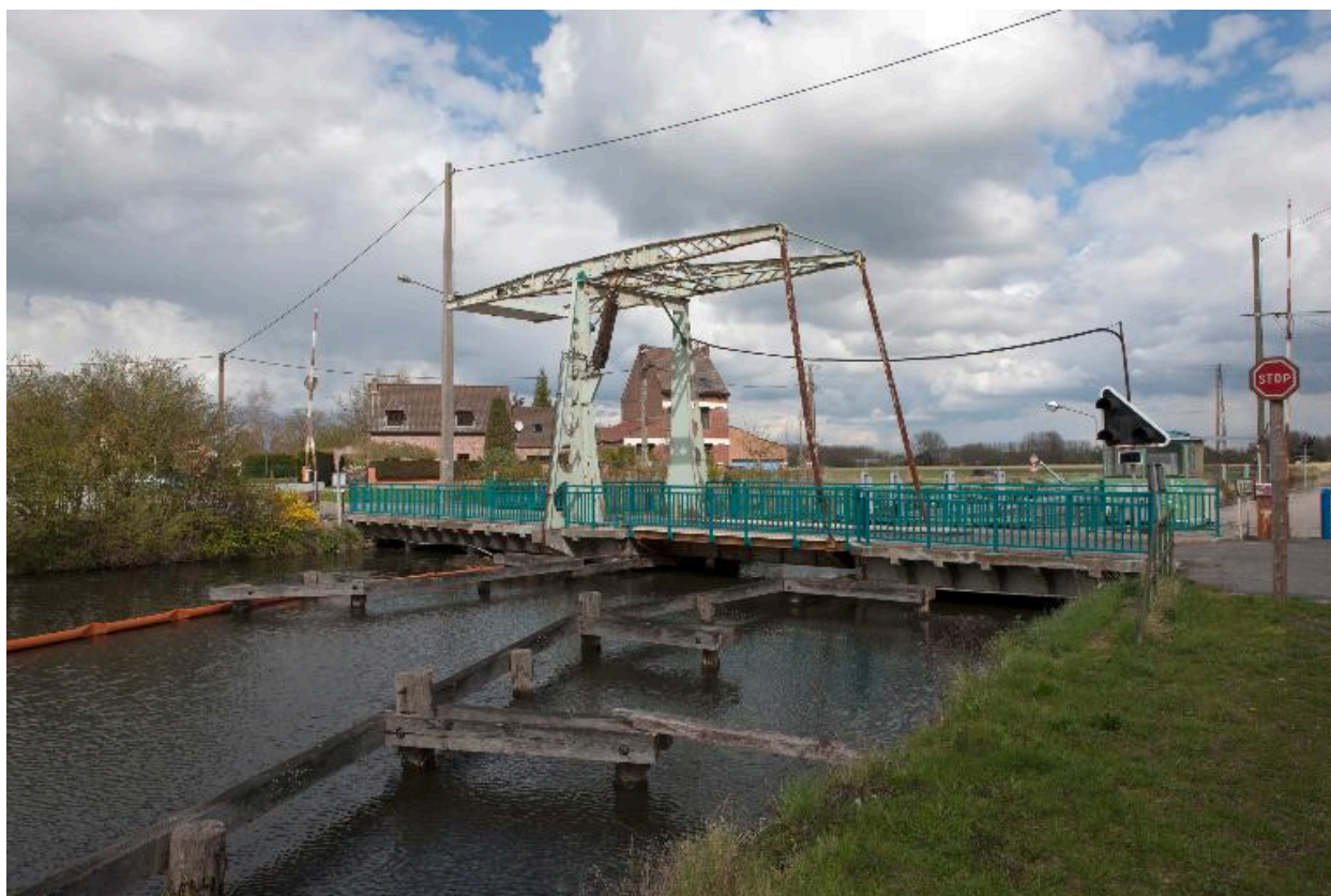
Le pont mobile sur la Scarpe.
