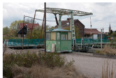
Vue générale de l'écluse de Warlaing. Phot. Pierre Thibaut IVR31_20125901638NUCA
