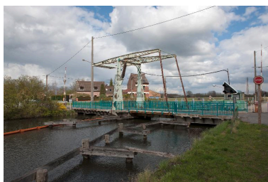
Le pont mobile sur la Scarpe. Phot. Pierre Thibaut IVR31_20125901631NUCA
