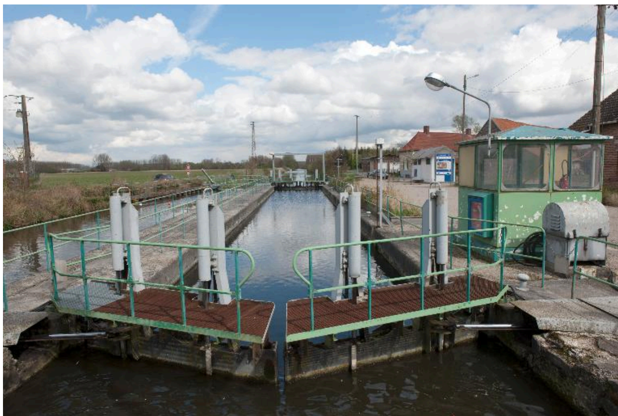
L'écluse de Warlaing.
