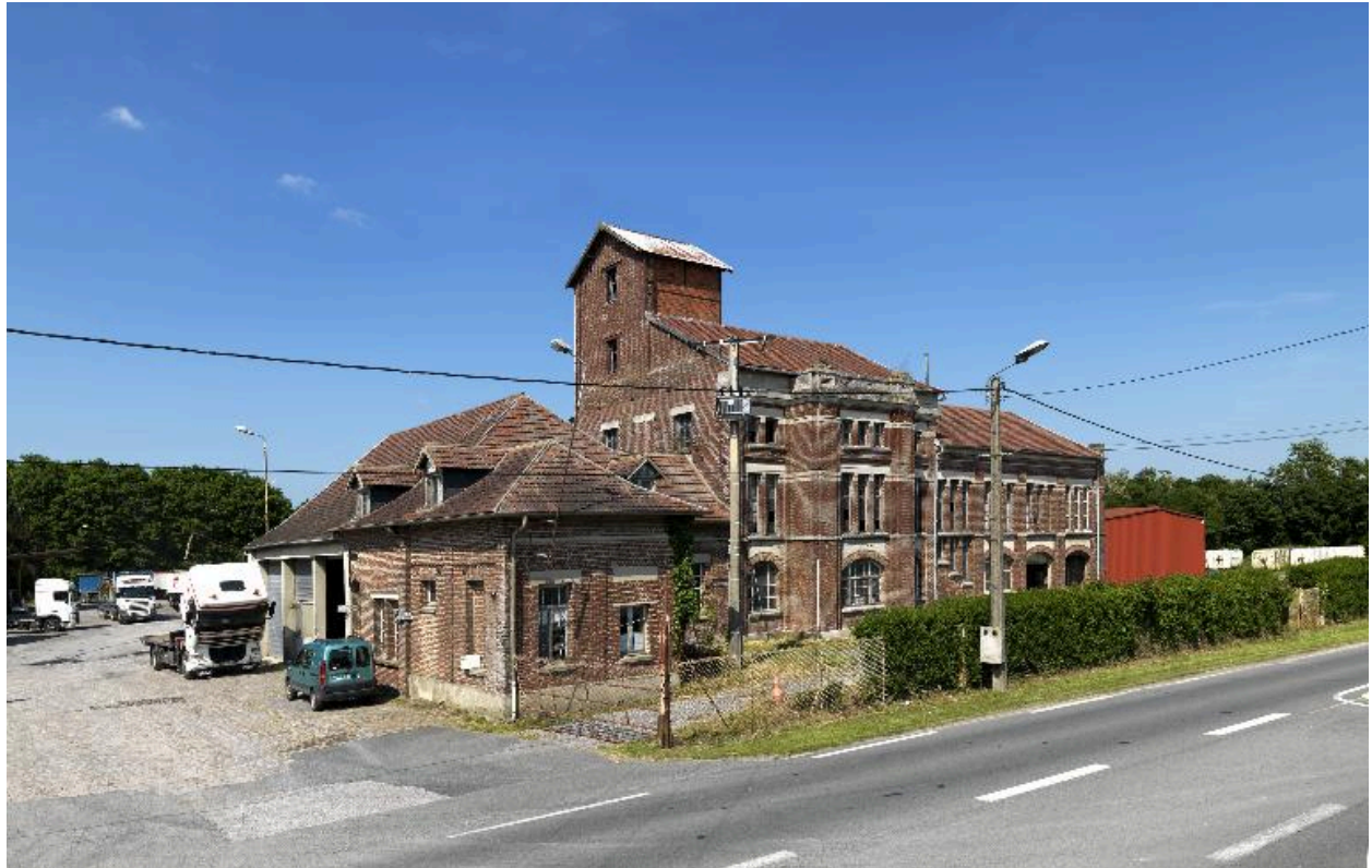
Vue d'ensemble de trois-quarts de la râperie.
