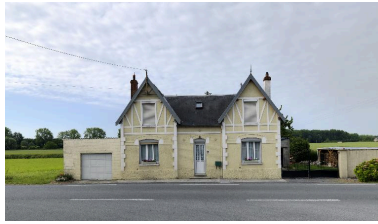
Logement dépendant de la râperie. Phot. Thierry Lefébure IVR22_20158000512NUC2A
