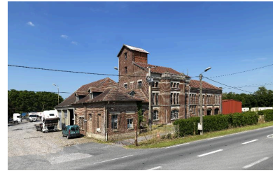
Vue d'ensemble de trois-quarts de la râperie. Phot. Thierry Lefébure IVR22_20158000291NUC2A
