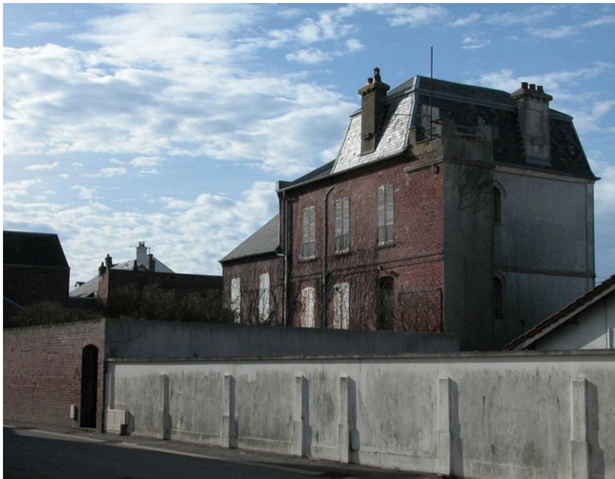
Elévation postérieure sur la rue Sainte-Catherine.
