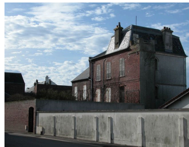
Elévation postérieure sur la rue Sainte-Catherine. Phot. Elisabeth Justome IVR22_20058002609NUCA
