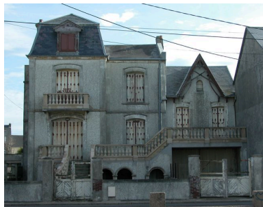
Vue d'ensemble, élévation antérieure. Phot. Elisabeth Justome IVR22_20058002608NUCA
