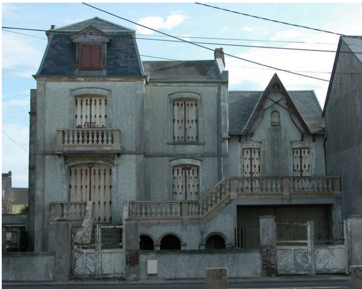
Vue d'ensemble, élévation antérieure.
