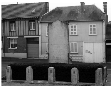
Vue postérieure. Phot. Martine Plouvier IVR22_19968000165Z
