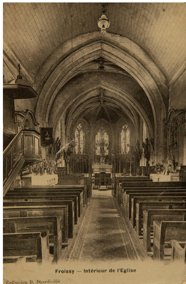
Froissy (Oise). Intérieur de l'église, carte postale, [premier quart du XXe siècle] (coll. part.). Repro. Marc Kérignard IVR32_20236000045NUCA
