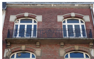
Vue sur le balcon en fer forgé du second étage, constitué de paniers à spirales et de vagues. Phot. Pierre Thibaut IVR31_20096200193NUCA
