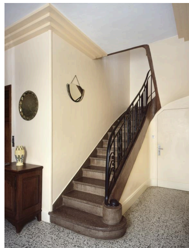
Vue de l'escalier en maçonnerie et fer forgé, réalisé par les ateliers Creusy-Véron de Ribemont. Phot. Thierry Lefébure IVR22_19990207192VA
