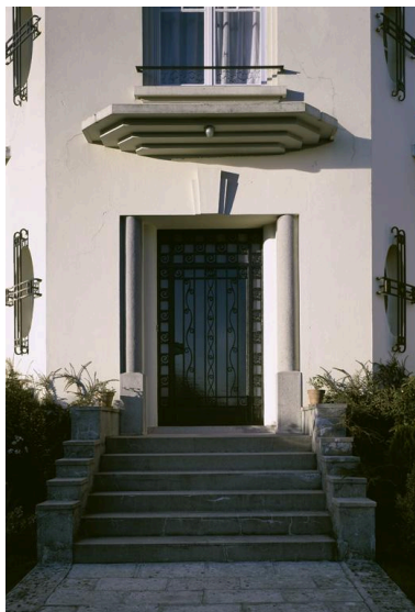
Détail du porche, et de la porte d'entrée en fer forgé. Phot. Thierry Lefébure IVR22_19990207196XA
