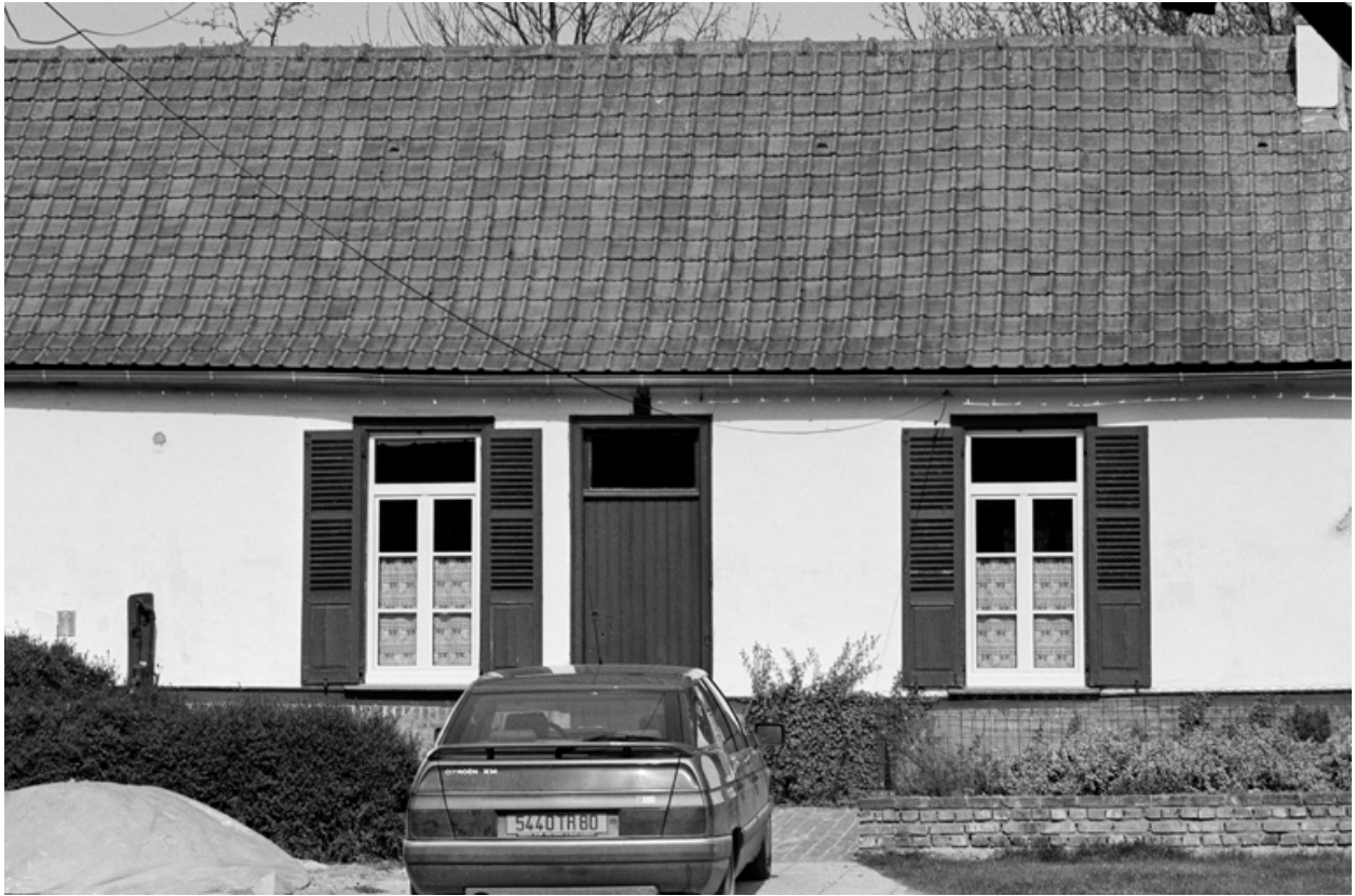
Façade antérieure du logis.
