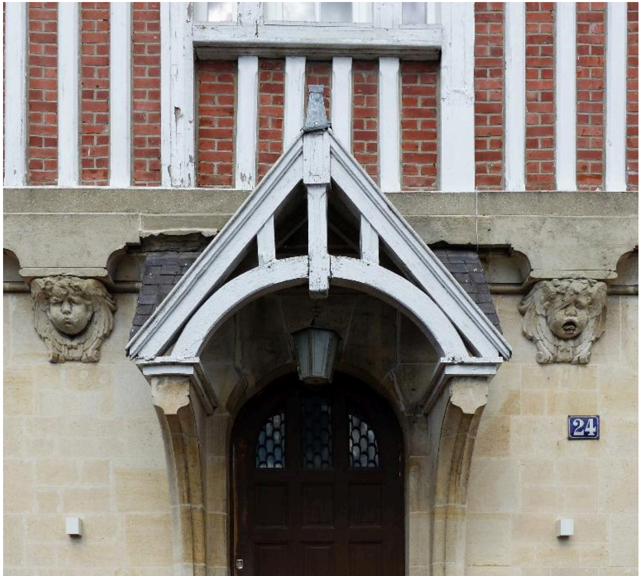
Vue de détail sur le porche.
