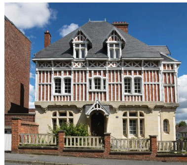
Façade, avenue Charles-Boulangier. Phot. Marie-Laure Monnehay-Vulliet IVR22_20158000714NUC2A
