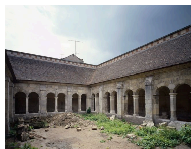
Cloître. Vue générale. Phot. Fabrice Charrondière IVR22_19866000160VA
