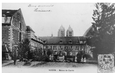
Vue générale d'ouest en est. Avant 1914 (AP). Phot. Jean-Michel Périn IVR22_19856000507XB
