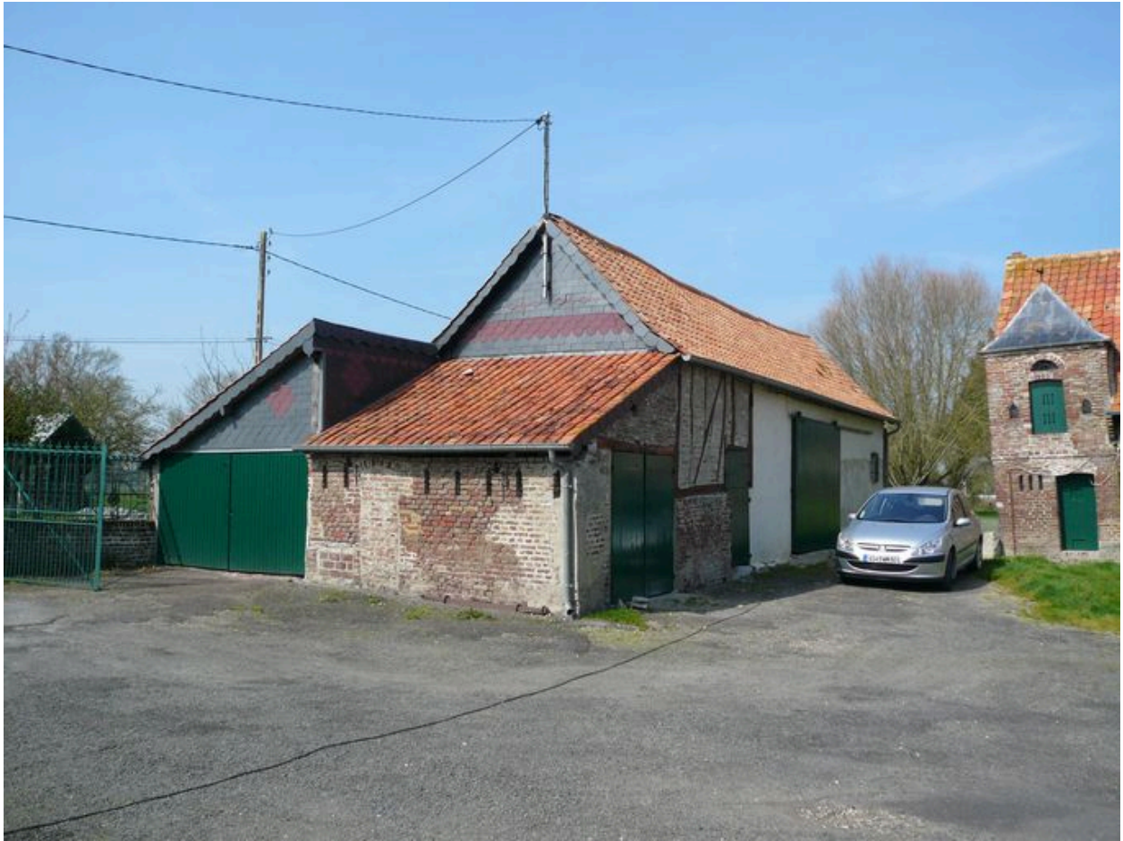
Vue de la grange située à l'ouest de la cour le long de la rue.
