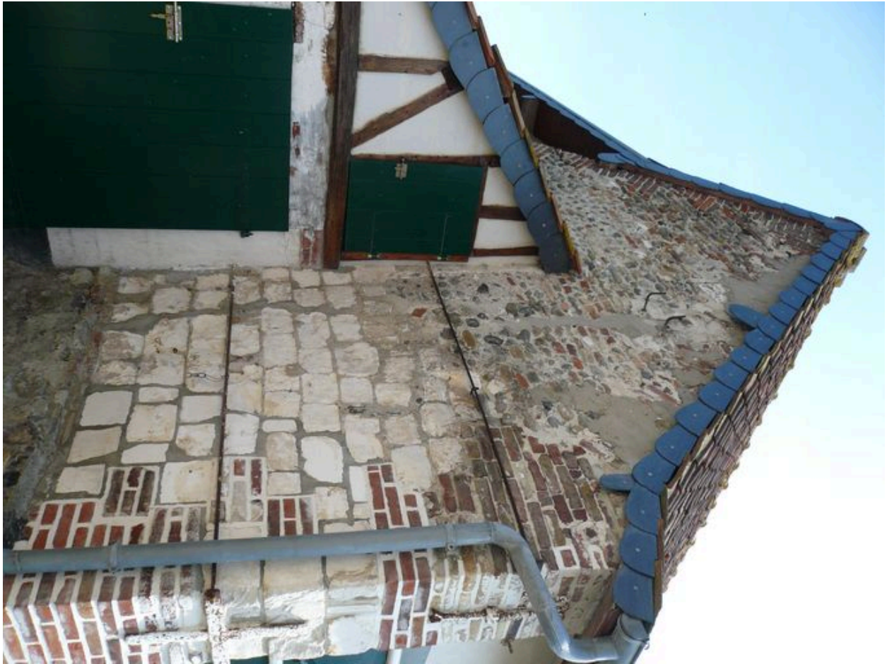
Vue du pignon nord.
