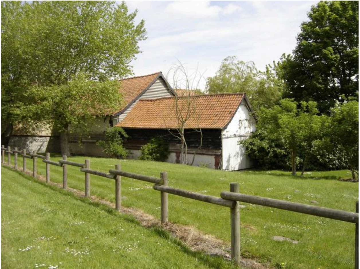
Vue sur la grange depuis la cour.
