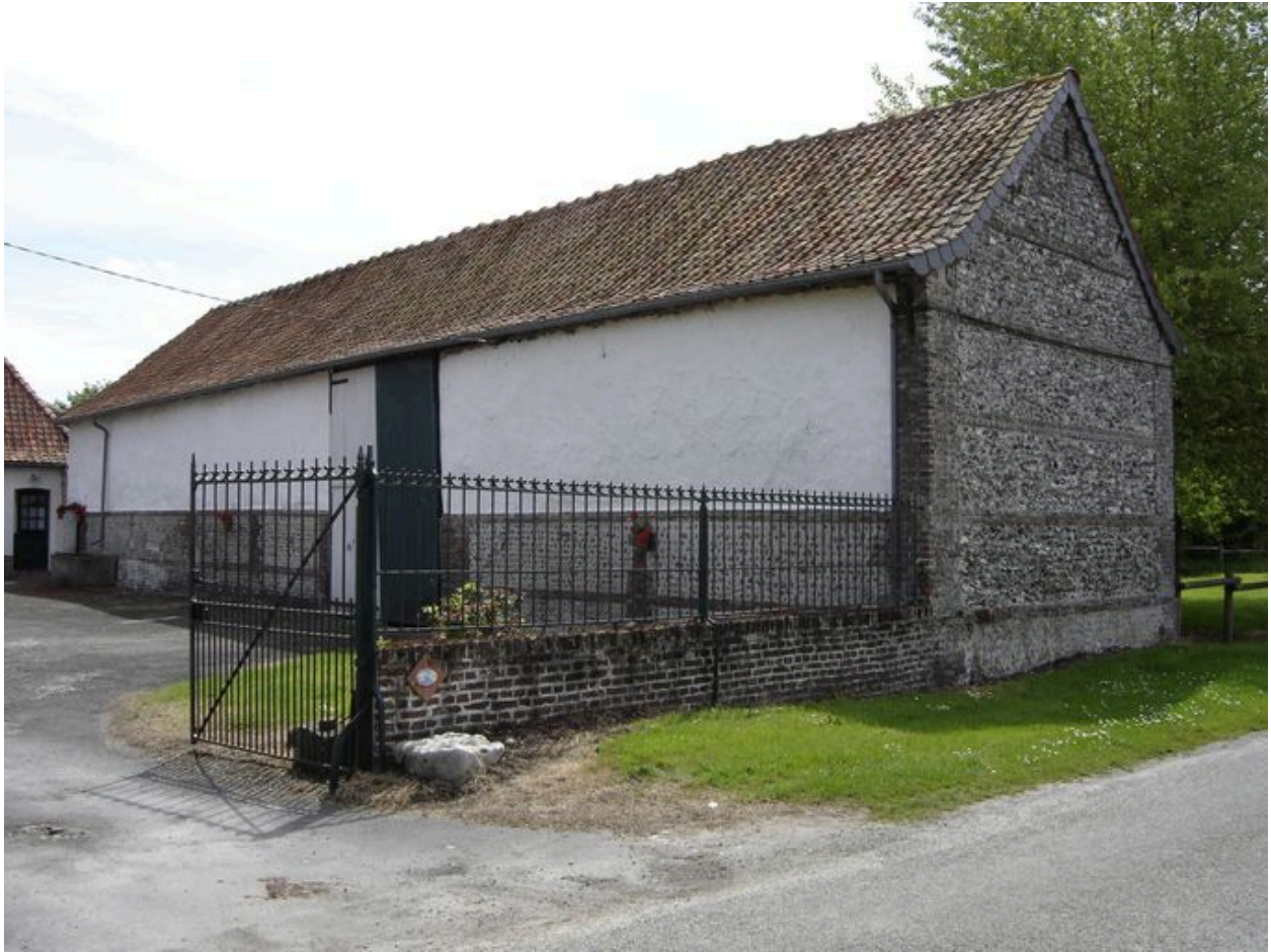
Vue postérieure depuis la rue de la grange sud.
