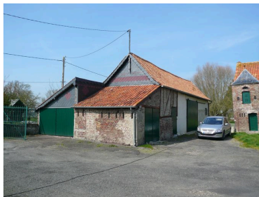
Vue de la grange située à l'ouest de la cour le long de la rue. Phot. Inès Guérin IVR22_20078005945NUCA
