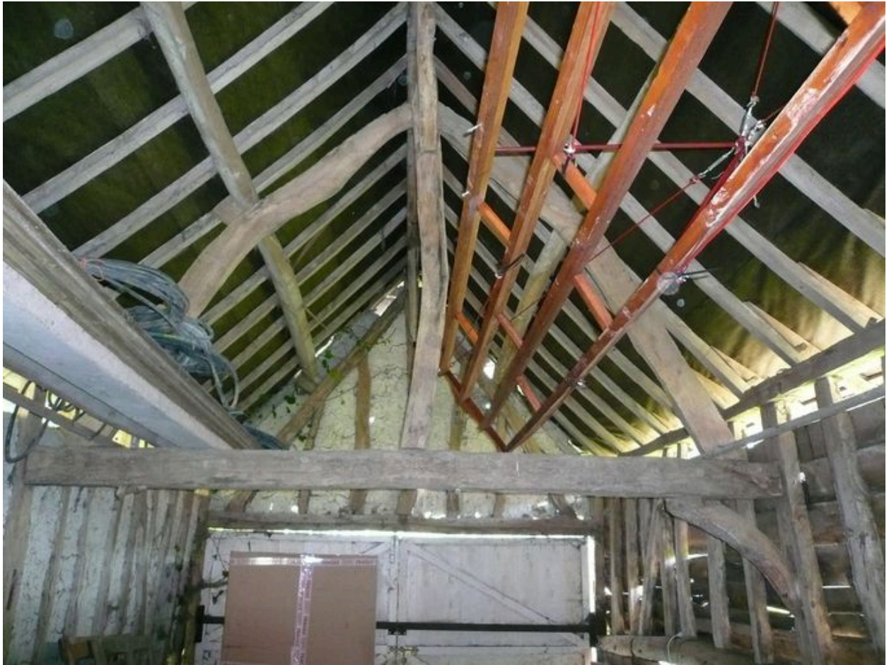
Vue intérieure de l'aire à battre.
