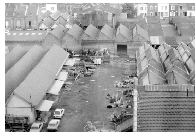
Magasin industriel, cour. Phot. Thierry Lefébure IVR22_19888000194Z
