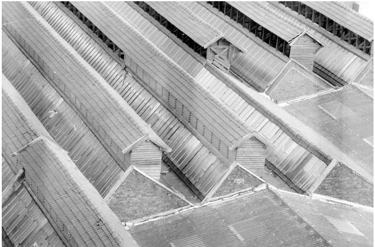
Atelier de fabrication, détail des sheds.
