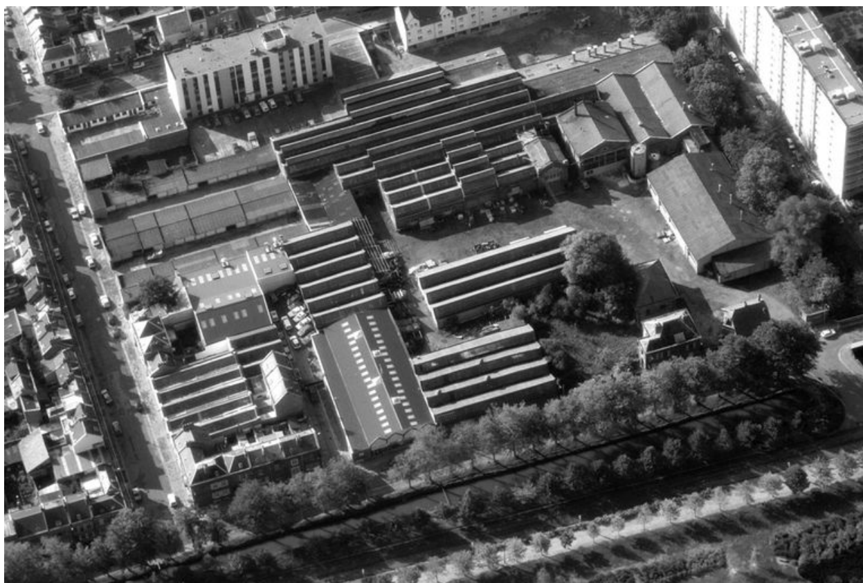
Vue aérienne, flanc nord.
