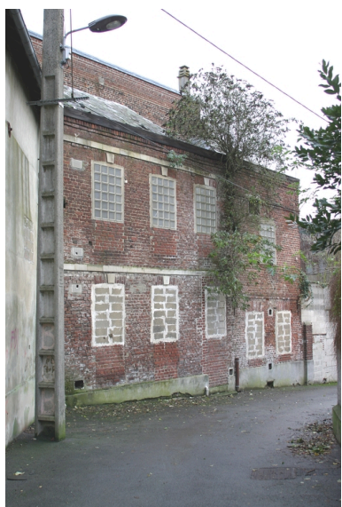
Logements en bordure de l'impasse Garant. Phot. Frédéric Pillet IVR22_20070205084NUCA
