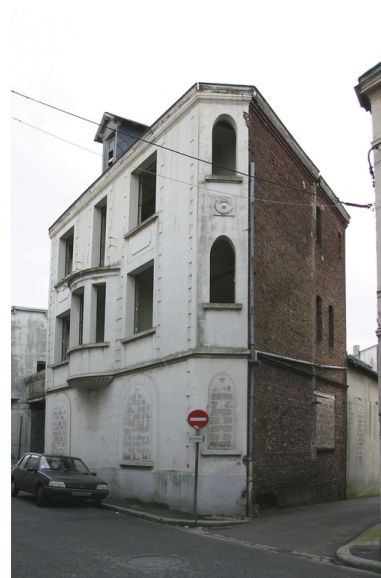
Le logement patronal à l'angle de la rue de Bagatelle et de l'impasse Garant. Phot. Frédéric Pillet IVR22_20070205083NUCA
