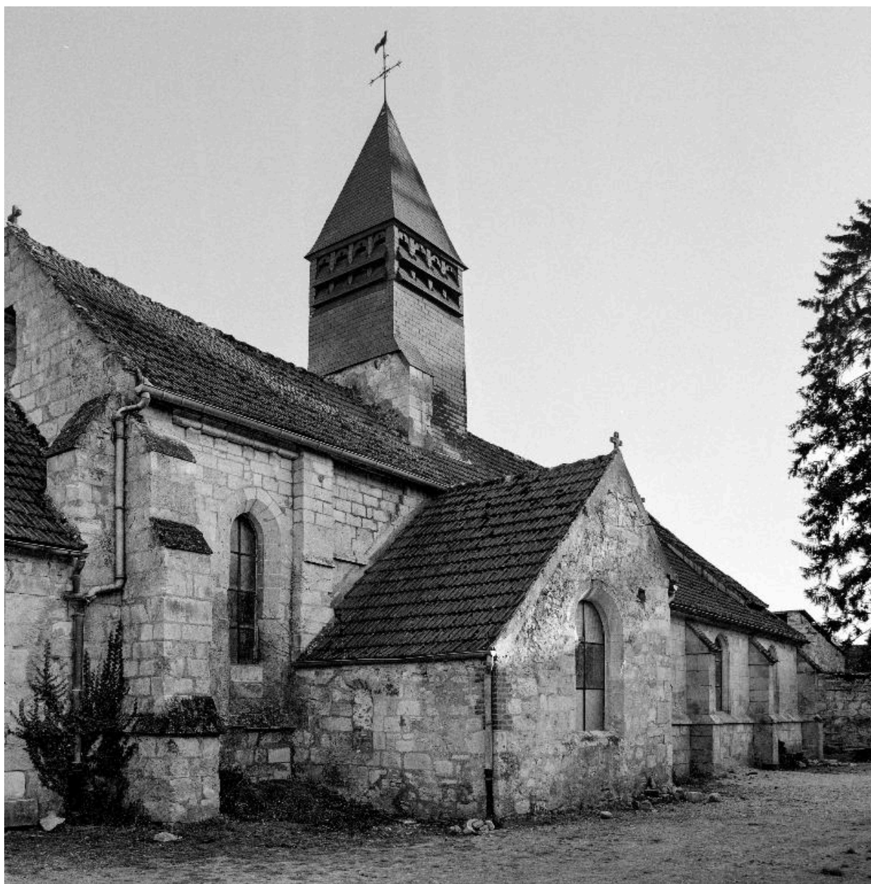
Vue de l'élévation nord de l'église.
