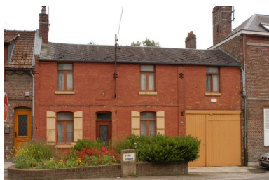
Vue de situation, maison au premier plan. Phot. Thierry Lefébure IVR22_20038000521NUCA
