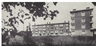
Vue en 1950. L'architecture aujourd'hui, octobre-novembre 1950, p. 101. Phot. Isabelle Barbedor IVR32_20210205036NUCA
