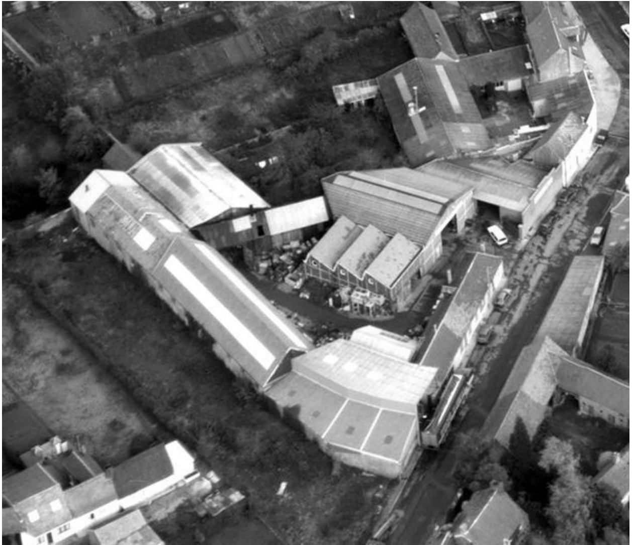
Vue aérienne, flanc sud-ouest.
