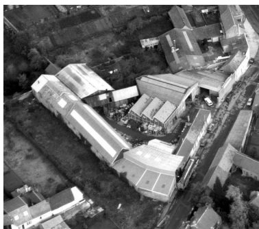
Vue aérienne, flanc sud-ouest.
