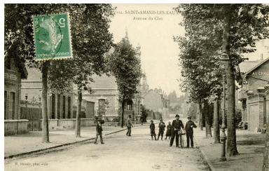
Vue générale de la rue Dumoulin, appelée du Clos, carte postale, 1er quart du 20e siècle (Médiathèque Saint-Amand-les-eaux). IVR31_20135908105NUCA
