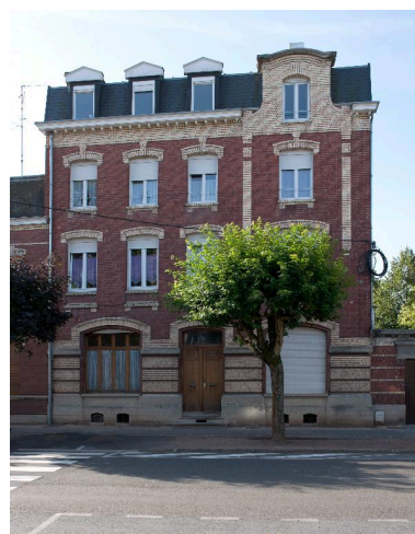
Immeuble, début XXe siècle (?), 6 avenue du Clos. Phot. Pierre Thibaut IVR31_20125902167NUCA
