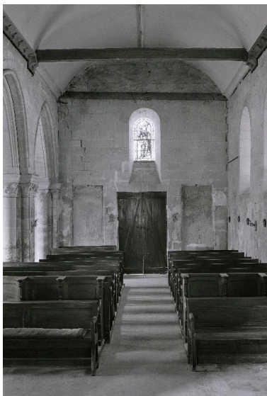
Vue intérieure de la nef, depuis le chœur vers l'entrée. Phot. Christiane Riboulleau IVR22_19880201219X
