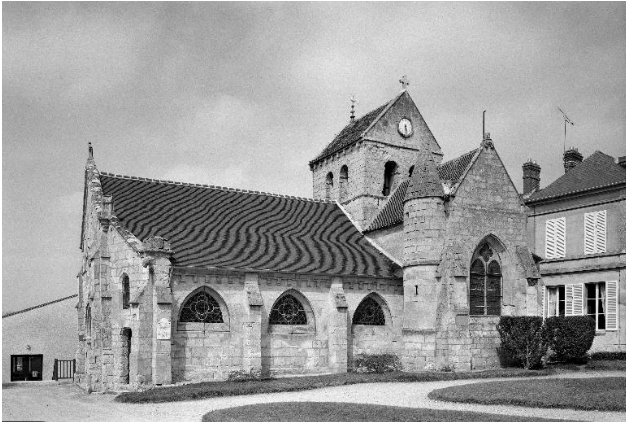
Vue générale de l'église depuis le sud-ouest.
