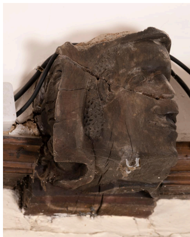
Blochet sculpté de la charpente du chœur : figure humaine. Phot. Marc Kérignard IVR32_20226001004NUCA
