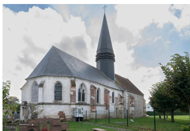
Vue depuis le nord-est. Phot. Marc Kérignard IVR32_20226001029NUCA
