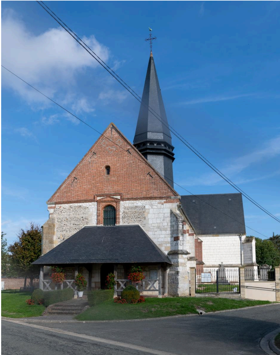
Vue de la façade occidentale.
