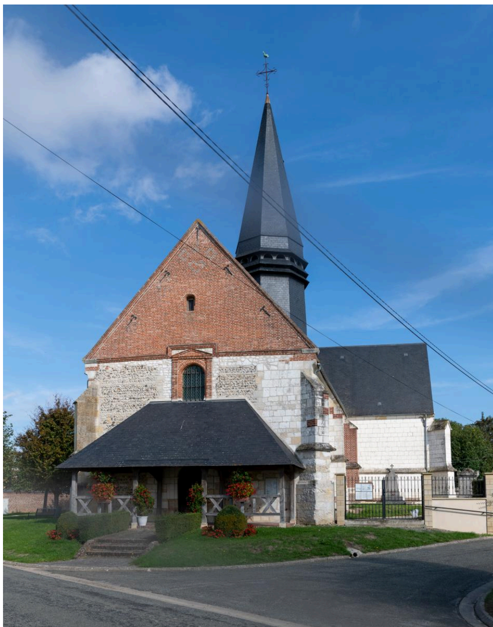
Vue de la façade occidentale.
