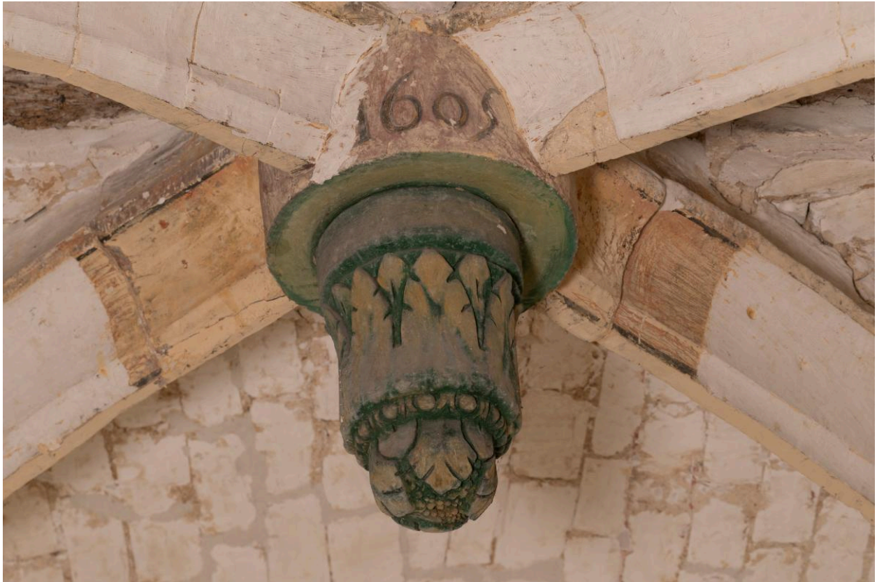
Clé pendante de la voûte de la chapelle de sainte Évrost avec date portée (1605).
