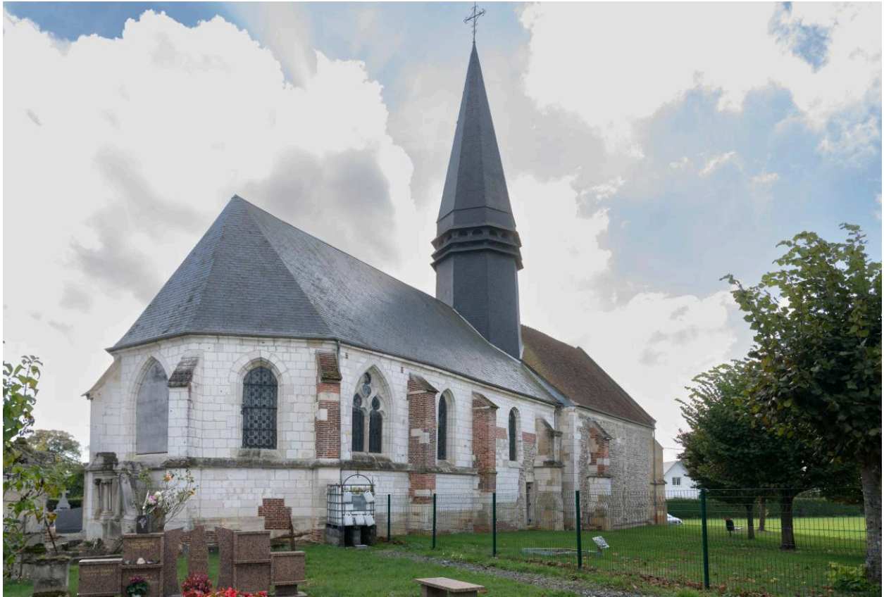
Vue depuis le nord-est.
