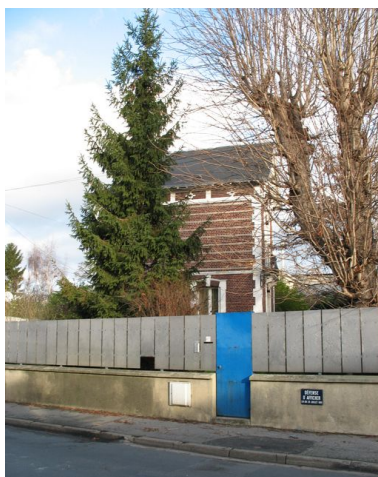
Entrée du logement sur la rue Jean-de-la-Fontaine entouré par une clôture en plaques d'aluminium. Phot. Clarisse Lorieux IVR22_20066005116NUCA
