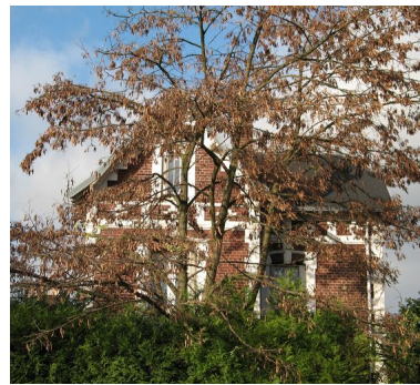
Le logement depuis la cour de l'usine. Phot. Clarisse Lorieux IVR22_20066005117NUCA
