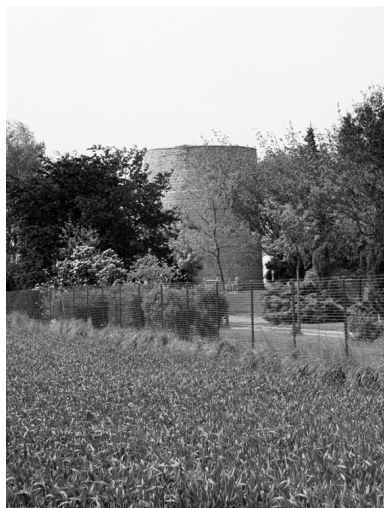
Le moulin Arrachard. Phot. Judith Förstel IVR22_20018000284Z
