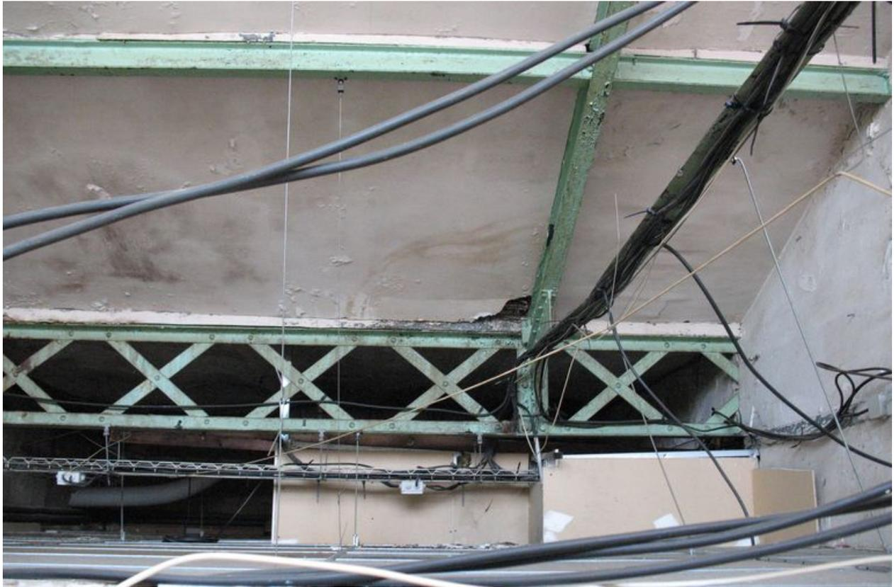
Détail d'une poutrelle métallique sous les sheds.
