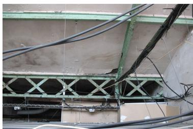
Détail d'une poutrelle métallique sous les sheds.
