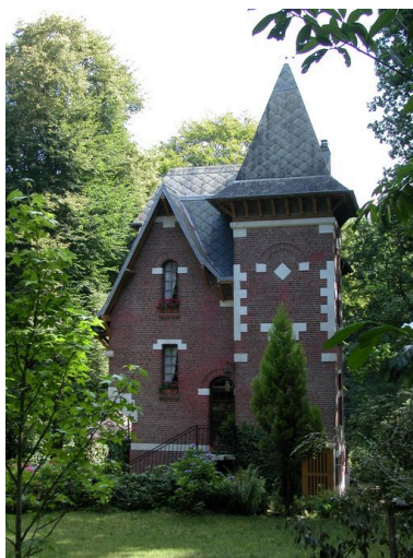
Vue d'ensemble depuis l'allée Marie. Phot. Elisabeth Justome IVR22_20058003311NUCA
