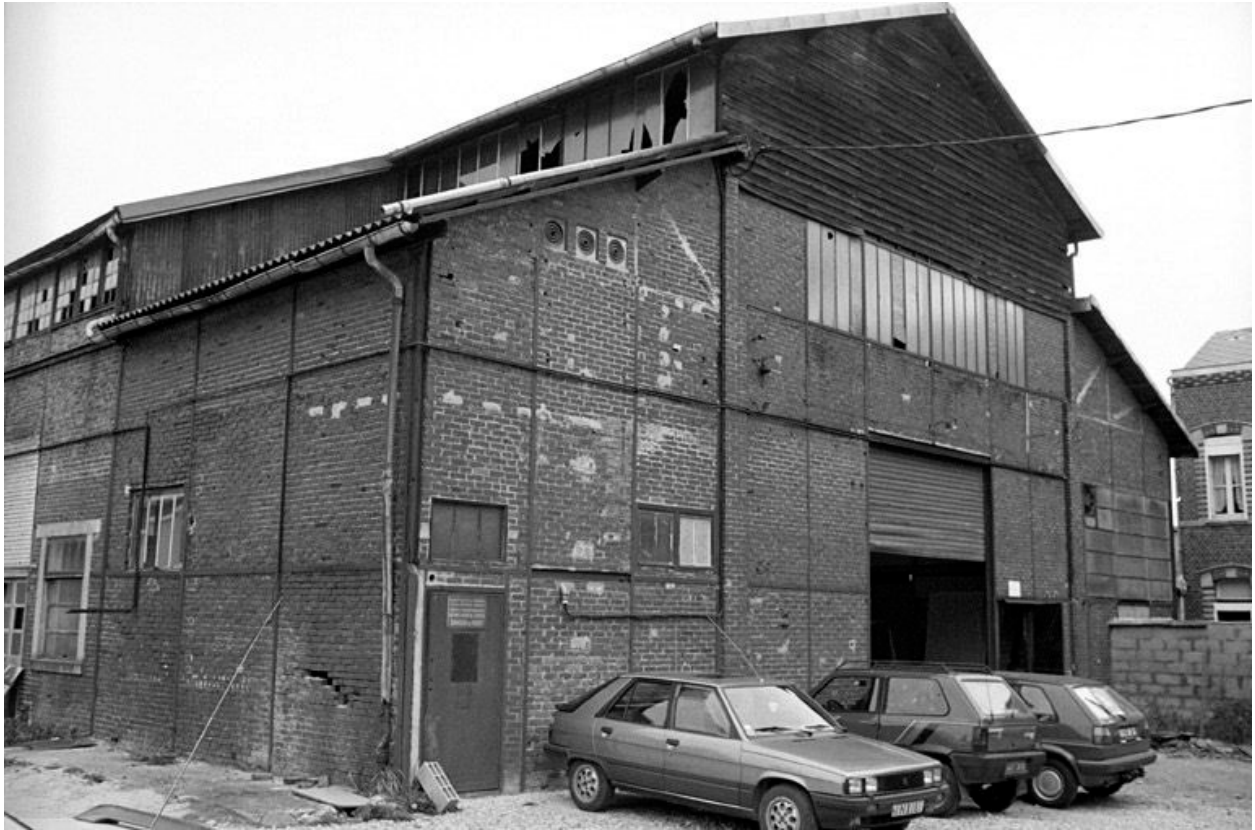
Atelier de fabrication, élévation antérieure.
