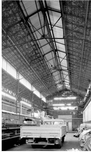
Atelier de fabrication : vue intérieure. Phot. Francis Dubuc IVR22_19908001025Z
