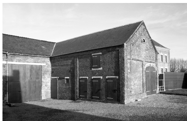
Bâtiment est, à usage d'étable et de remise. Phot. Thierry Lefébure IVR22_19960200931X
