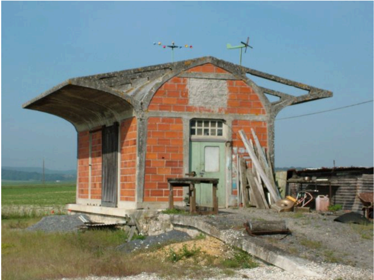
Vue du bâtiment de stockage.
