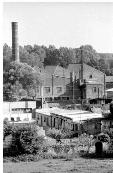
Vue partielle de l'usine. Phot. Benoît Dufournier IVR22_19878000163Z
