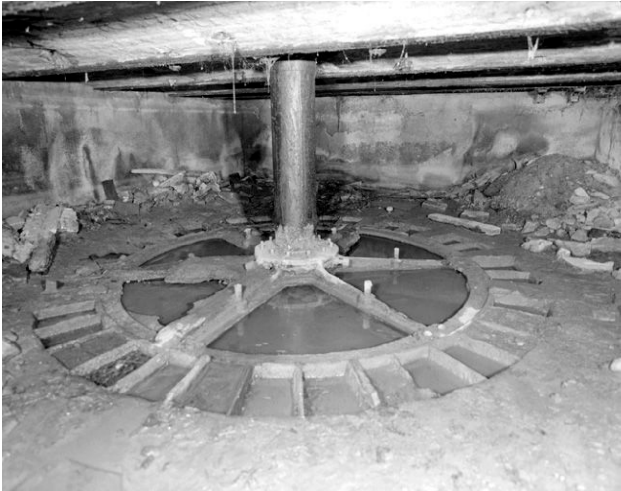
Bâtiment d'eau : turbine hydraulique.
