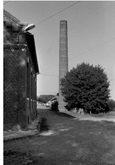
Cheminée d'usine. Phot. Benoît Dufournier IVR22_19878000166Z
