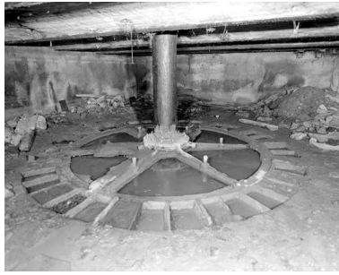
Bâtiment d'eau : turbine hydraulique. Phot. Jacques Philippot IVR22_19878000234X
