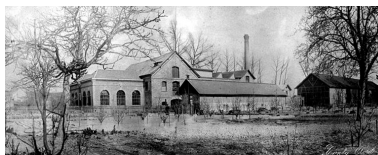
Vue de la salle des machines, photographie, vers 1890 (coll. part.). Phot. Philippot Jacques IVR22_19878000229XB
