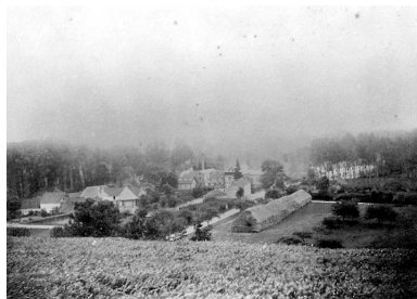
Vue générale de l'usine, photographie, vers 1890 (coll. part.). Phot. Philippot Jacques IVR22_19878000226XB
