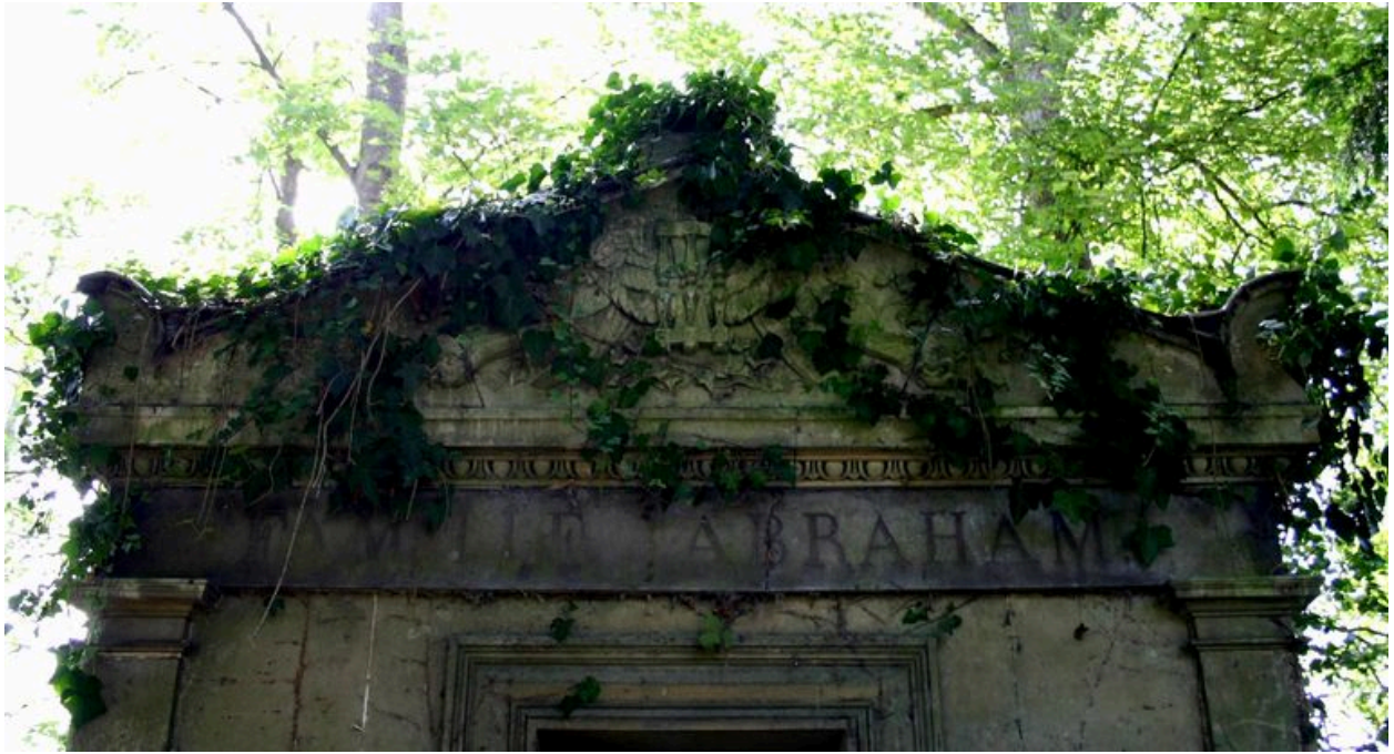
Fronton ornant la façade antérieure du tombeau-chapelle.
