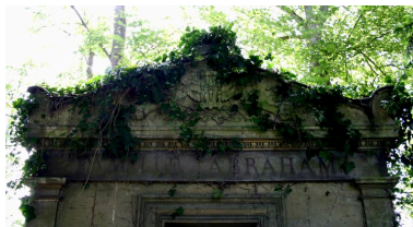
Fronton ornant la façade antérieure du tombeau-chapelle. Phot. Caroline Vincent IVR22_20078000927NUCA
