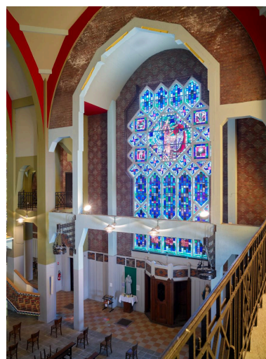
Verrière du bas-côté sud illustrant la Sainte Famille. Phot. Pierre Thibaut IVR32_20215900075NUCA
