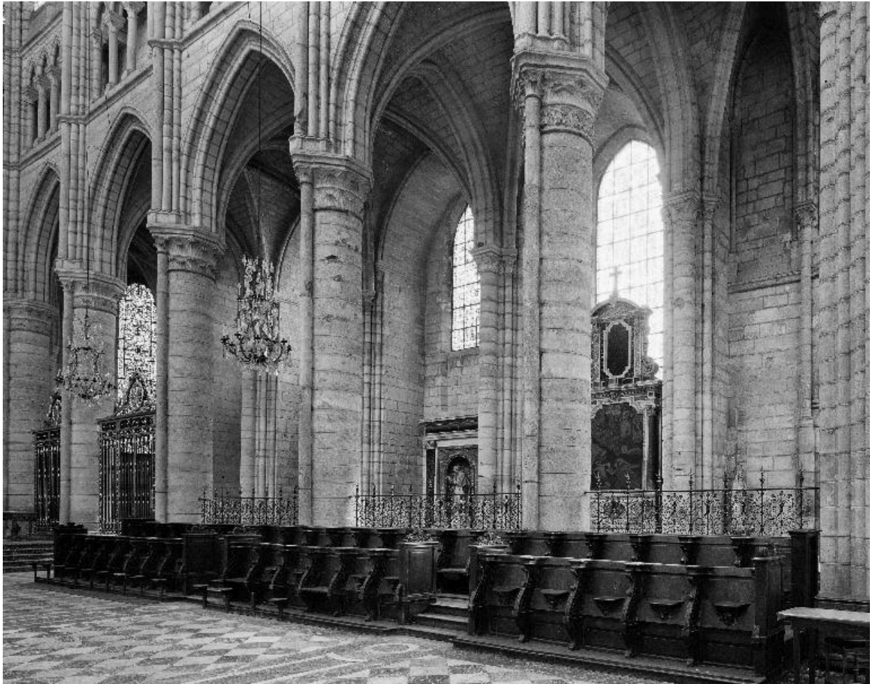
Vue des deux rangs de stalles qui longent le côté sud du chœur.
