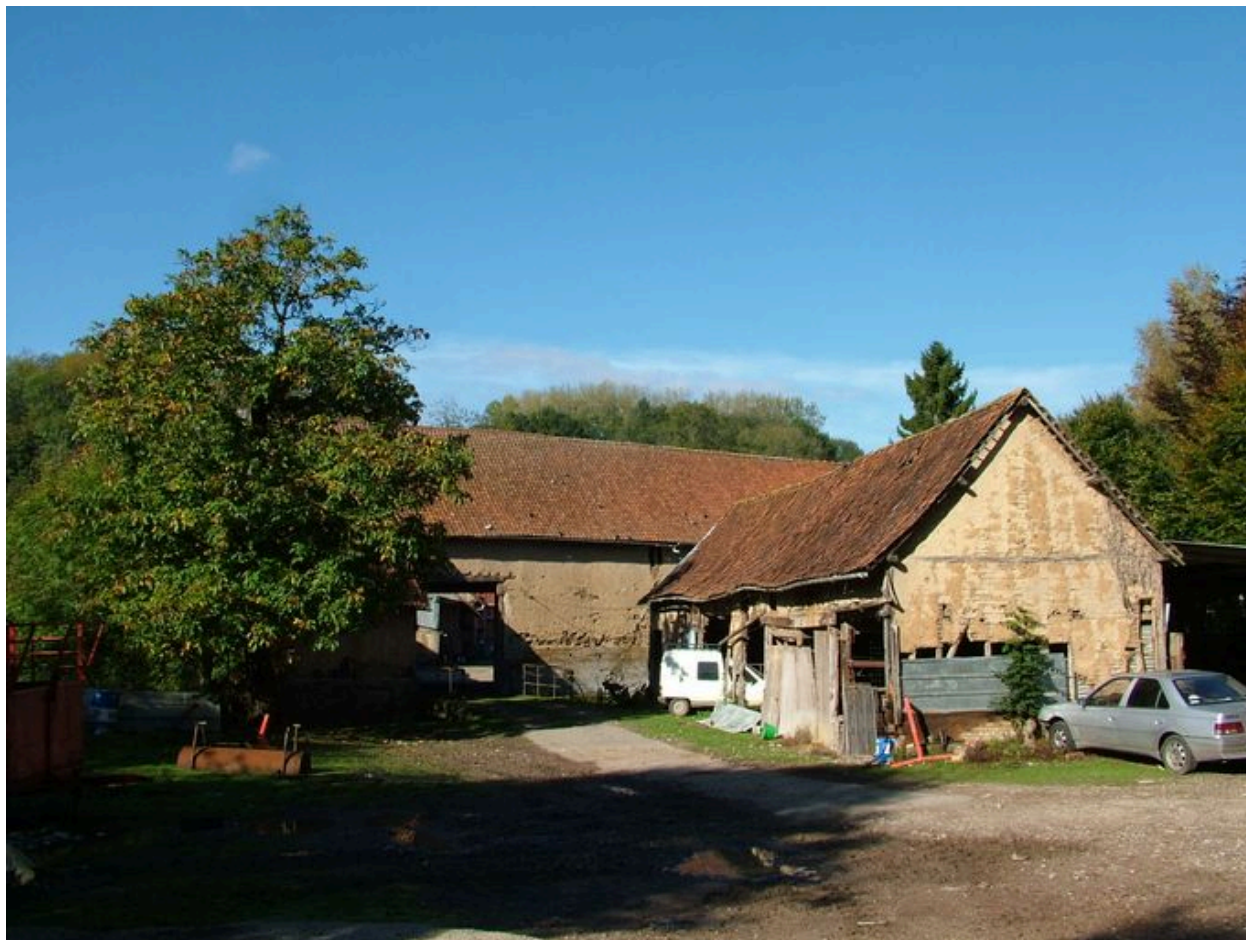
Vue des granges depuis la cour arrière.
