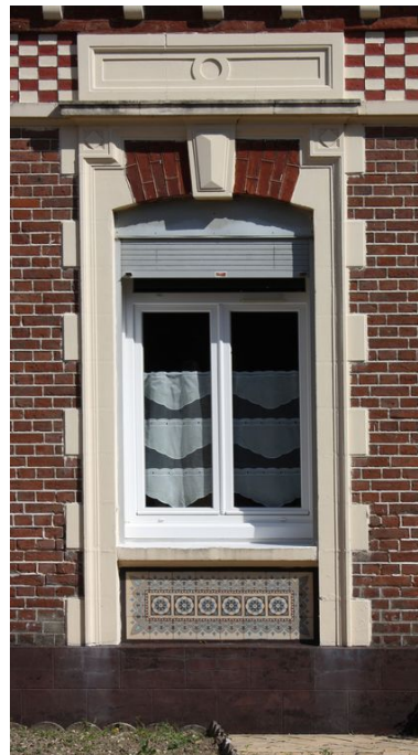
Détail d'une travée de la façade principale. Phot. Bertrand Fournier IVR22_20098005020NUCA
