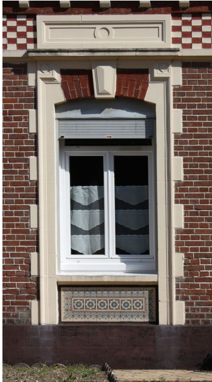
Détail d'une travée de la façade principale.
