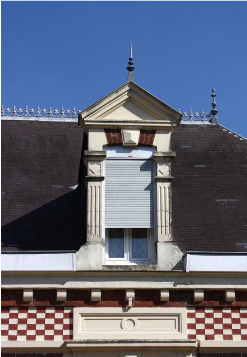
Détail de la corniche en damier et de la lucarne passante.
