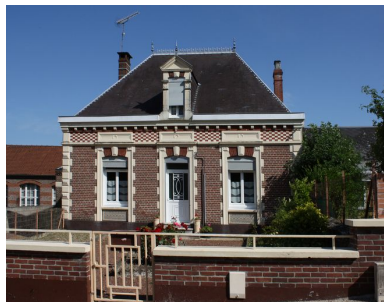
Vue générale. Phot. Bertrand Fournier IVR22_20098005018NUCA
