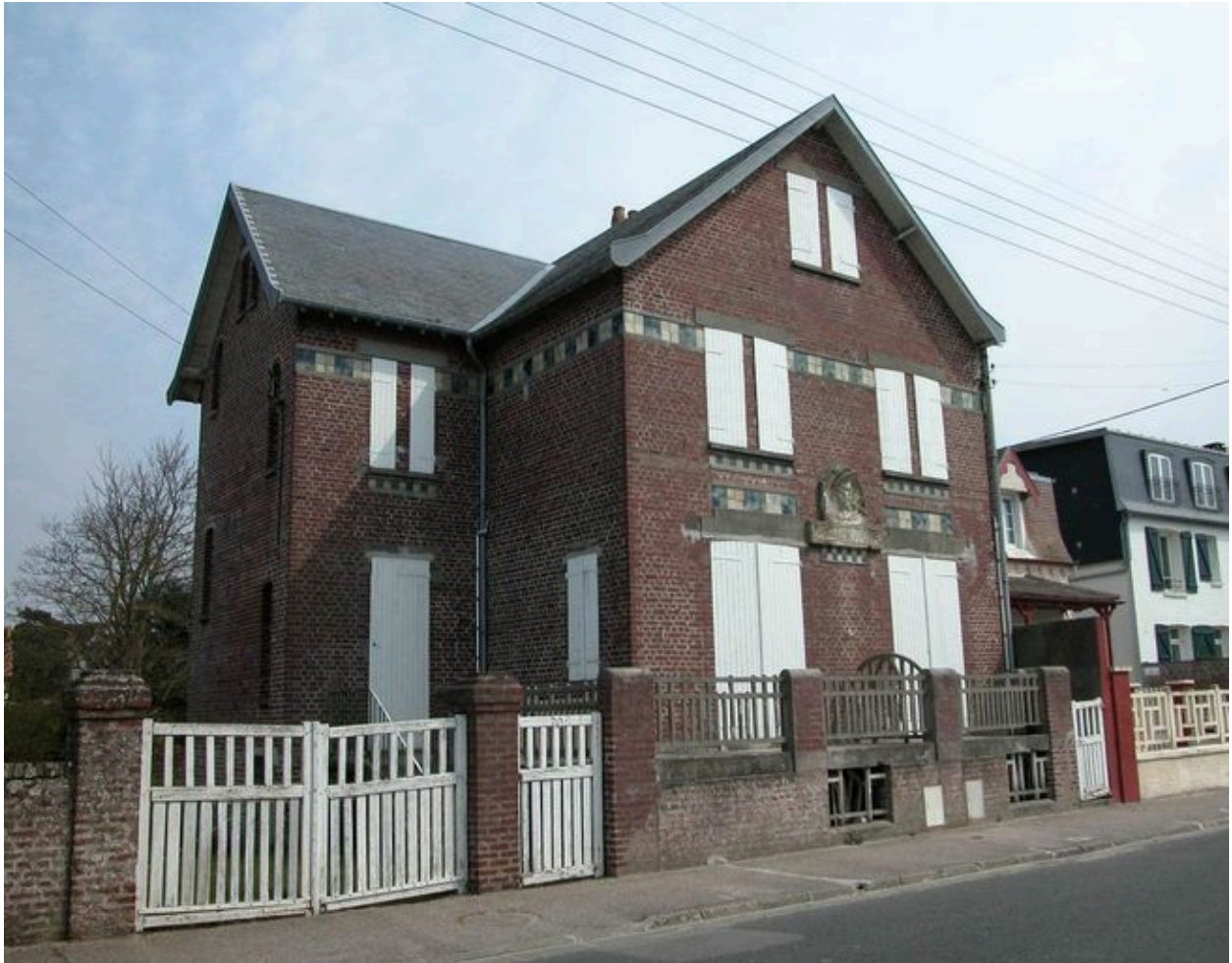
Vue d'ensemble depuis la rue Guy-Dath.
