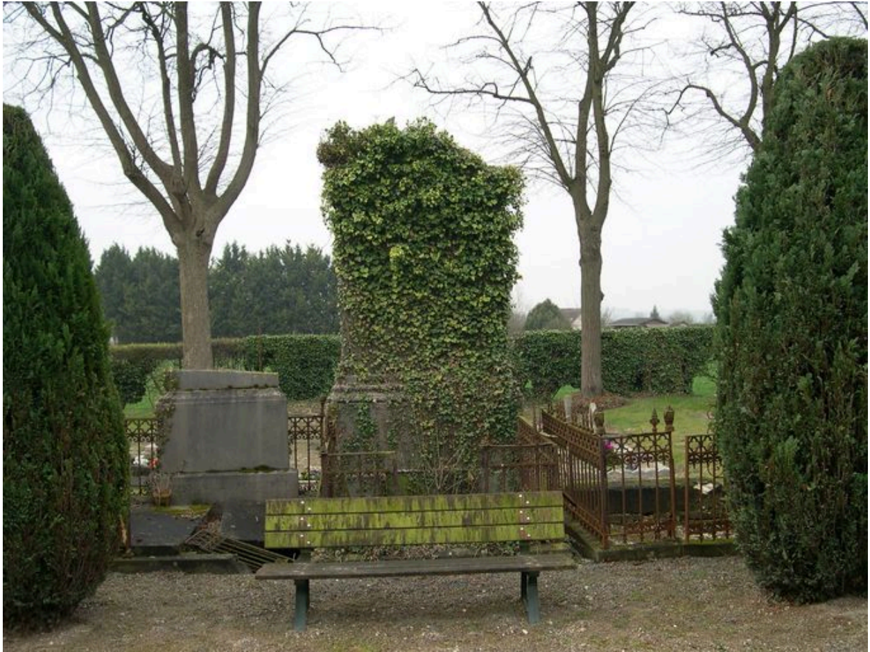
Partie ancienne du cimetière. Allée principale (rive sud). Tombeaux en mauvais état.
