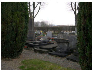
Partie ancienne du cimetière. Allée principale (rive nord). Tombeaux en mauvais état. Phot. Isabelle Barbedor IVR22_20058010230NUCA
