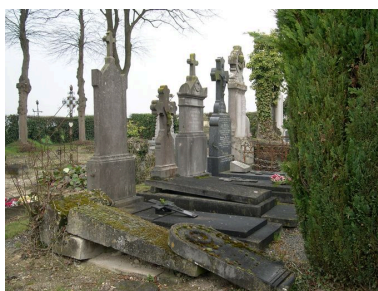
Partie ancienne du cimetière. Allée principale (rive sud). Tombeaux en mauvais état. Phot. Isabelle Barbedor IVR22_20058010228NUCA
