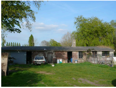
Vue des dépendances. Phot. Inès Guérin IVR22_20078005926NUCA
