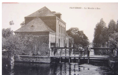
Vue du moulin hydraulique, de son vannage de décharge composé de quatre vannes et d'un déversoir au début du 20e siècle.
