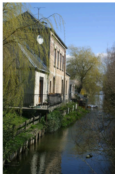
Vue postérieure. Phot. Irwin Leullier IVR22_20078000137NUCA
