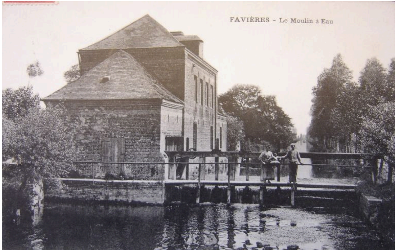
Vue du moulin hydraulique, de son vannage de décharge composé de quatre vannes et d'un déversoir au début du 20e siècle.
