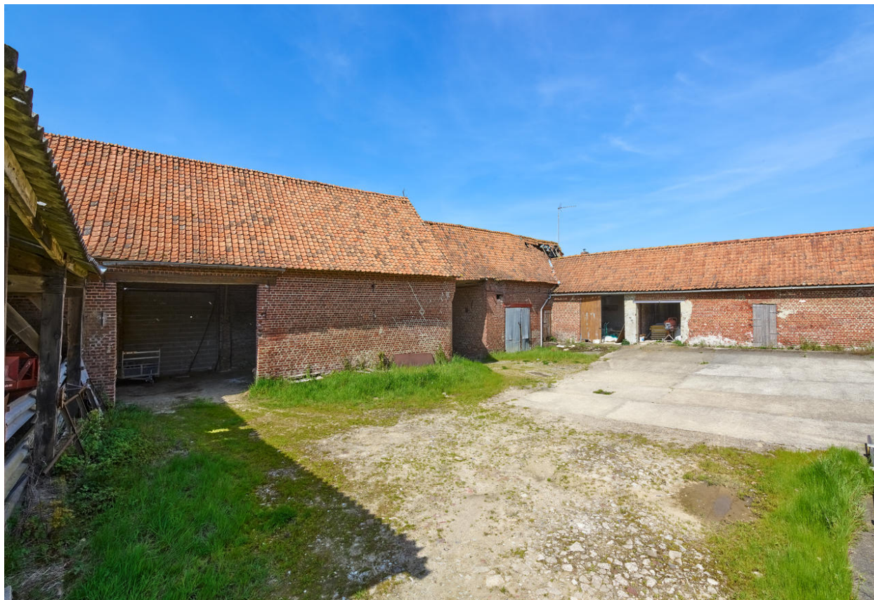
Vue de la grange et d'une partie des porcheries depuis le sud-ouest.
