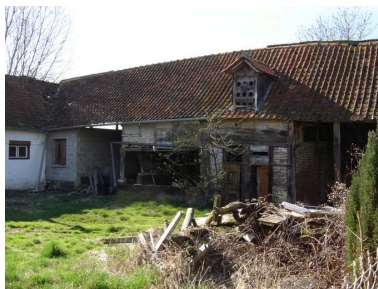
Vue des anciennes dépendances agricoles. Phot. Inès Guérin IVR22_20058005412NUCA
