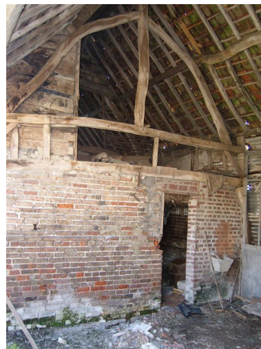
Vue de la charpente de la grange. Phot. Inès Guérin IVR22_20058005413NUCA
