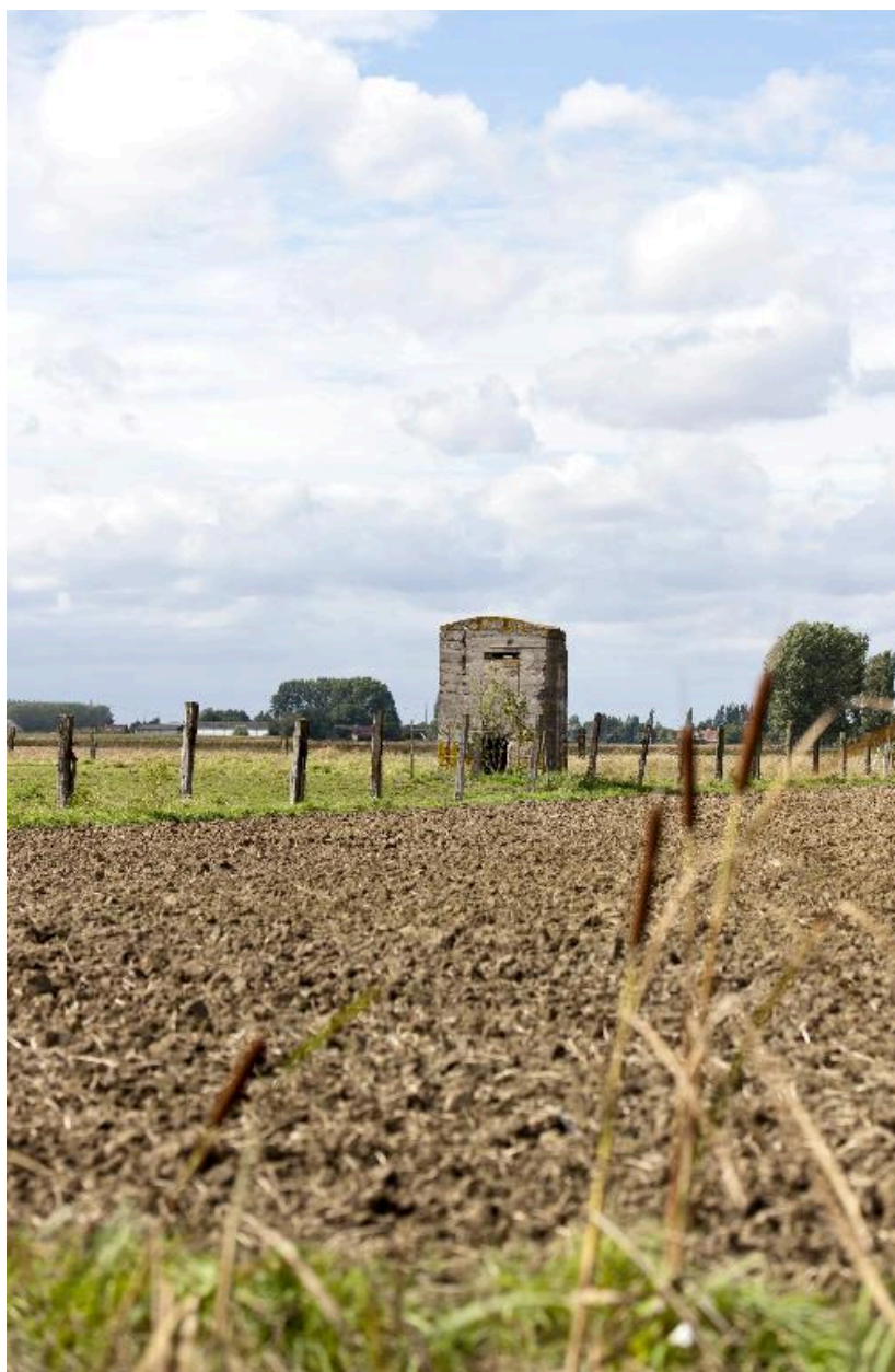
Aubers, casemate de communication optique 191.
