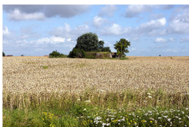
Fournes-en-Weppes, casemate à mitrailleuse 71, sous la végétation. Phot. Jean-Marc Ramette IVR31_20145904508NUCA
