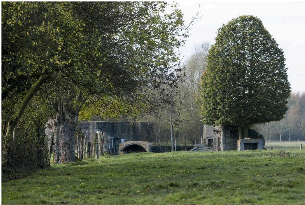
Illies, ensemble fortifié au lieu-dit Lannoy.
