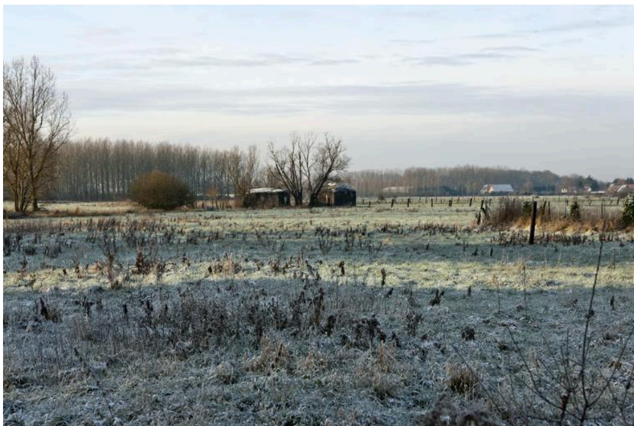
Aubers, ensemble de deux casemates 193, sous la neige.
