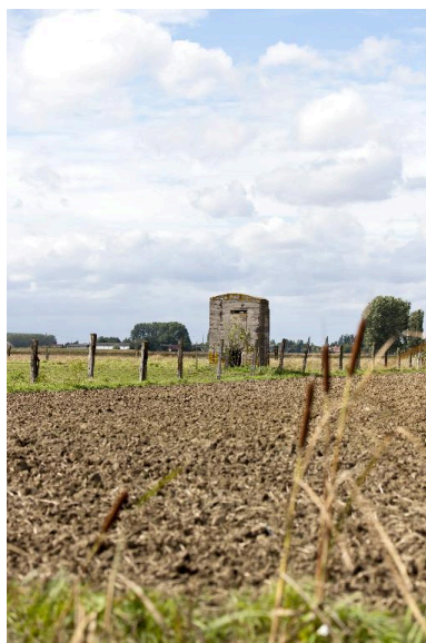
Aubers, casemate de communication optique 191. Phot. Jean-Marc Ramette IVR31_20145904232NUCA
