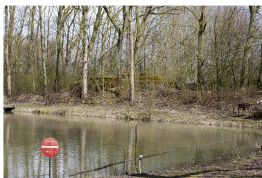
Aubers, casemate de commandement 303 sous la végétation. Phot. Jean-Marc Ramette IVR31_20145904412NUCA
