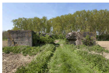
Herrin, casemate à personnel 225 coupée par le milieu. Phot. Jean-Marc Ramette IVR31_20145904858NUCA
