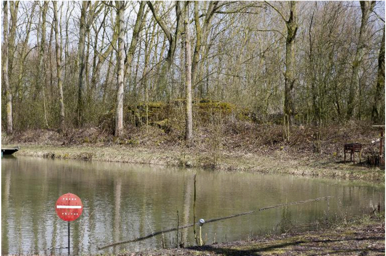
Aubers, casemate de commandement 303 sous la végétation.
