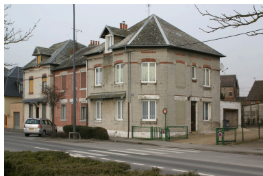
Groupe de trois logements. Phot. Frédéric Pillet IVR22_20060205109NUCA
