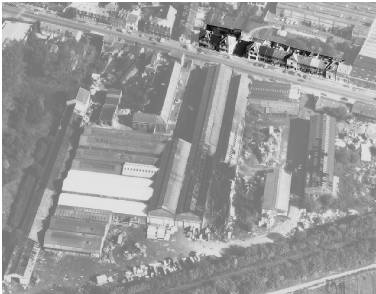
Vue aérienne en 1989 : au premier plan, les anciens ateliers Mariolle.
