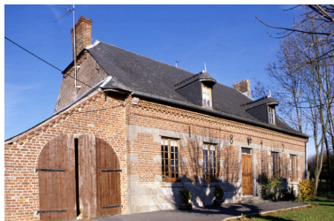
Vue générale du logis. Phot. Christiane Riboulleau IVR22_19960200028ZA
