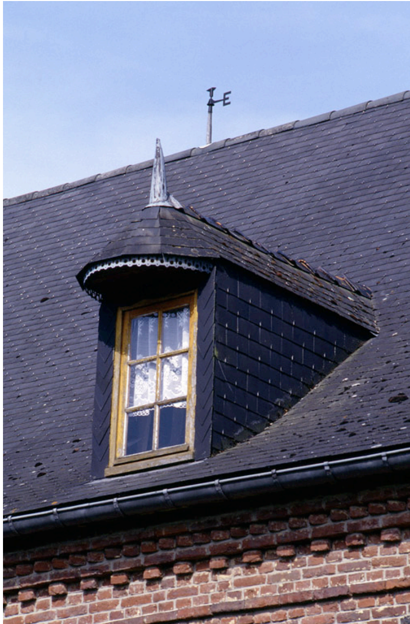
Détail d'une lucarne de la façade du logis.
