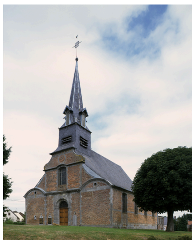
Vue générale sud-ouest. Phot. Thierry Lefébure IVR22_19960200598VA
