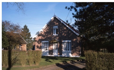
Vue générale. Phot. Pierre Thibaut IVR31_20095901351VA
