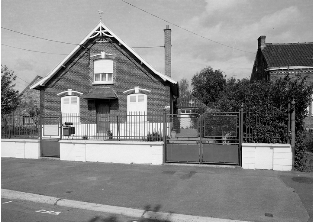
Vue générale de la maison située 212, rue de la Résistance.
