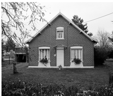
Vue générale. Phot. Philippe Dapvril IVR31_20045901097X
