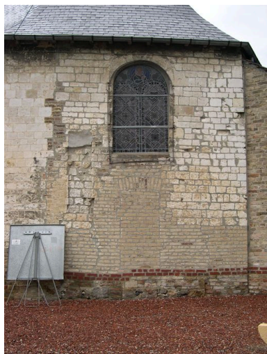
Détail du mur sud du chœur. Phot. Isabelle Barbedor IVR22_20038010504NUCA
