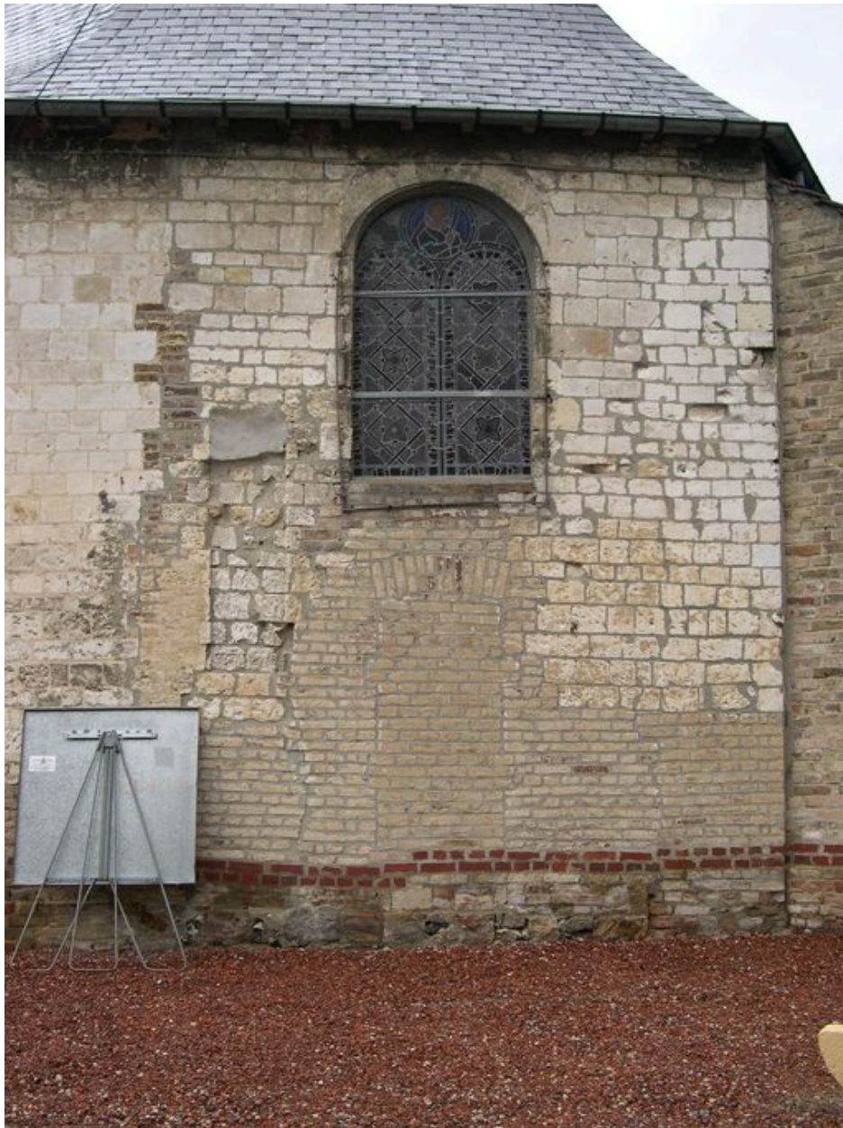
Détail du mur sud du choeur.
