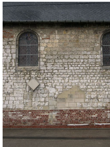
Détail du mur sud. Phot. Isabelle Barbedor IVR22_20038010503NUCA
