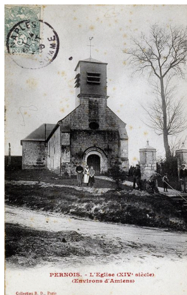
Vue générale, avant 1906 (coll. part.). Phot. Monnehay-Vulliet Marie-Laure IVR22_20108000055XA
