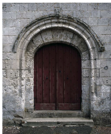
Portail occidental. Phot. Marie-Laure Monnehay-Vulliet IVR22_20098000248XA
